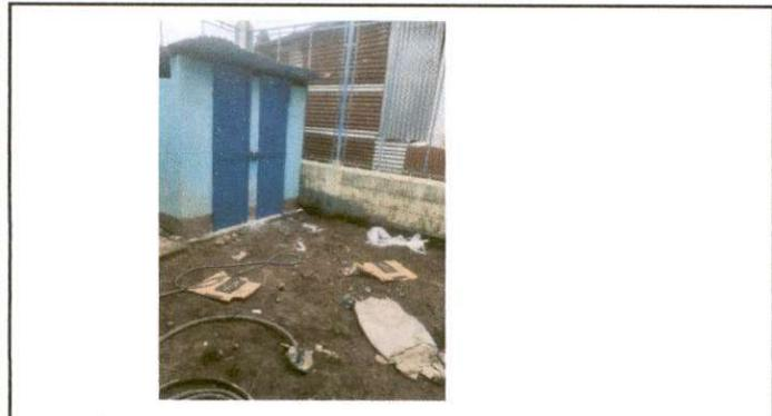
Foto 3: Sustitución de dos puertas de madera por puertas de metal de dos baños del módulo 2.
