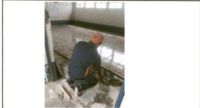
Foto 1: Sustitución de piso de cemento por piso de cerámico de 4 aulas que hacen un total de 284 metros cuadrados, incluyendo el corredor en el módulo 2
